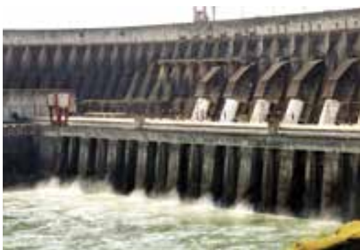
Barragem de usina hidrelétrica.
